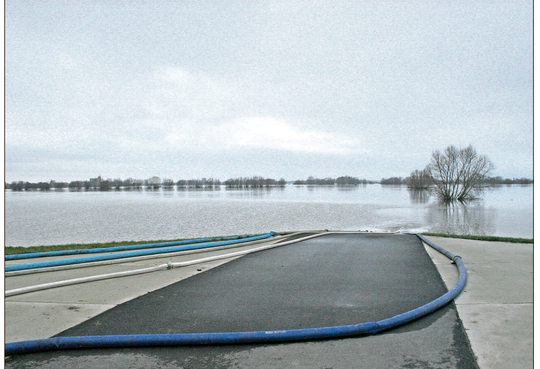
Mit mehreren Pumpen wurde der Deichgraben in Alt Wendischthun im Dauereinsatz abgepumpt.
