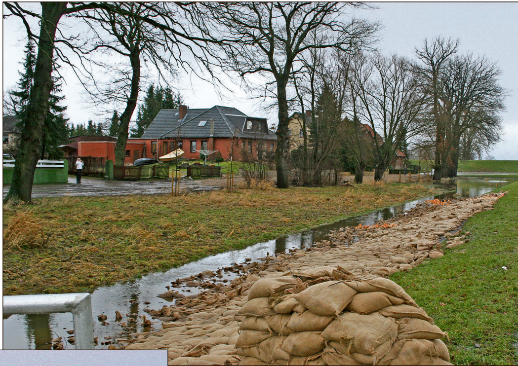
Weil die Böschung am Deich in Alt Wendischthun abrutschte, wurde der Deichgraben mit Matten und Sandsäcken befestigt.
