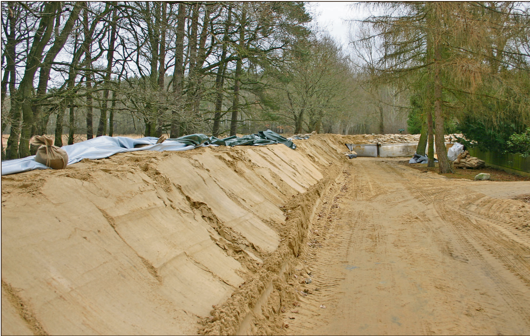
Der fertig gestellte Quick Damm in Alt Garge, Stiepeler Straße.
