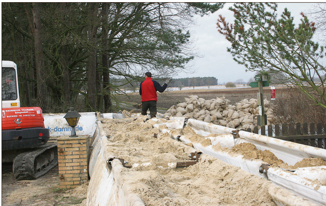
Aufbau eines Quick-Dammes in der Stiepeler Straße in Alt Garge
