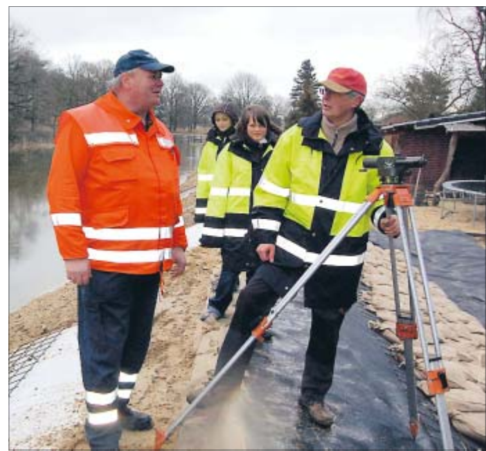
Henning Banse (l.) begutachtet mit Michael Sprätz, Sabrina Knoop und Jennifer Förster vom NLWKN die Deichbauten. Foto: kre
