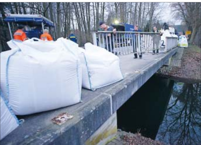
Tonnenschwere Big-Bags liegen bereit, versperren mittlerweile dem Elbe-Hochwasser den Zufluss in den Kateminer Mühlenbach. Foto: t & w
